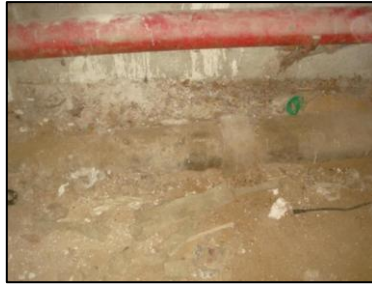
Photo N° 5771 AMIANTE CIMENT 2 COUPERIN-S.SOL-COULOIRS DE CAVES Conduits de fluide Chute E.U.(Fibres-ciment)
