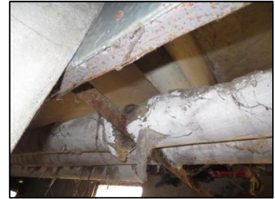
Photo N° 730 AMIANTE CIMENT 1 COUPERIN-LOCAL V.O +1 à +4 Vide-ordures Gaine V.O.(Fibres- ciment)
