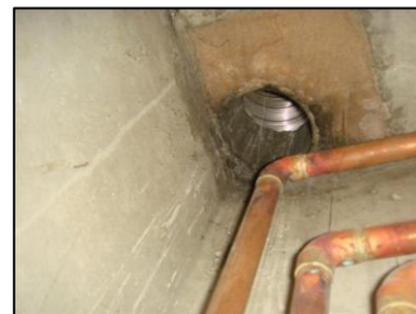
Photo N° 5773 AMIANTE CIMENT 4 COUPERIN--PLACARDS GAZ +4 Plafonds Ventilation haute (Fibres- ciment)
