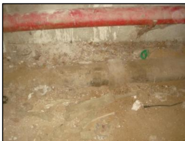
Photo N° 5771 AMIANTE CIMENT 4 COUPERIN-S.sol-COULOIRS DE CAVES Conduits de fluide Chute E.U.(Fibres-ciment)
