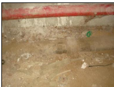
Photo N° 5771 AMIANTE CIMENT 8 COUPERIN-S.sol-COULOIRS DE CAVES Conduits de fluide Chute E.U.(Fibres-ciment)
