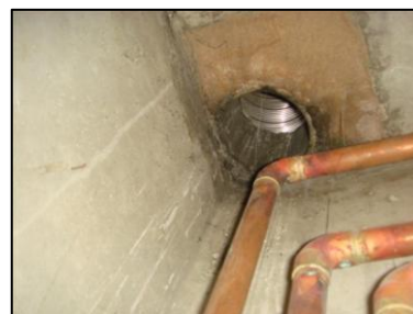
Photo N° 5773 AMIANTE CIMENT 8 COUPERIN--PLACARDS GAZ +4 Plafonds Ventilation haute (Fibres- ciment)
