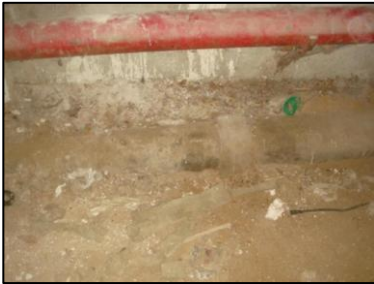
Photo N° 5771 AMIANTE CIMENT 10 COUPERIN-S.sol-COULOIRS DE CAVES Conduits de fluide Chute E.U.(Fibres-ciment)
