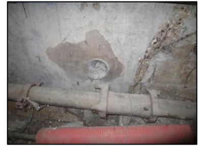
Photo N° 728 AMIANTE CIMENT 1 COUPERIN-S.sol-COULOIRS DE CAVES Planchers Chute E.U.(Fibres-ciment)
