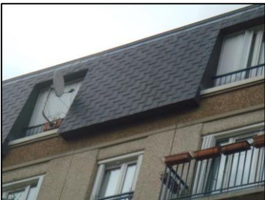
Photo N° 5776 ECH-N°1 1 COUPERIN-façades brisat Ardoises
