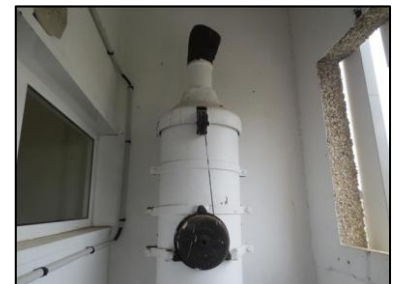
Photo N° 711 AMIANTE CIMENT 20 BLAISE--LOCAL V.O RDC à +4 Vide-ordures Gaine V.O.(Fibres-ciment)
