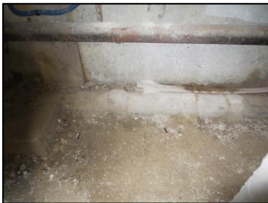
Photo N° 708 AMIANTE CIMENT 20 BLAISE-S.sol-COULOIRS DE CAVES Conduits de fluide Chute E.U.(Fibres-ciment)
