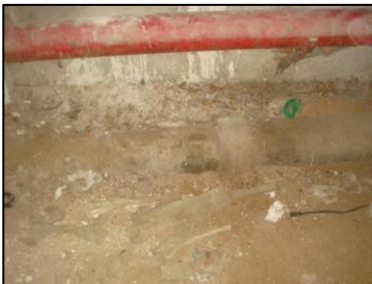
Photo N° 5771 AMIANTE CIMENT 12 COUPERIN-S.sol-COULOIRS DE CAVES Conduits de fluide Chute E.U.(Fibres-ciment)
