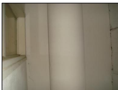
Photo N° 5772 AMIANTE CIMENT 12 COUPERIN--LOCAL V.O RDC à +4 Vide-ordures Gaine V.O.(Fibres- ciment)
