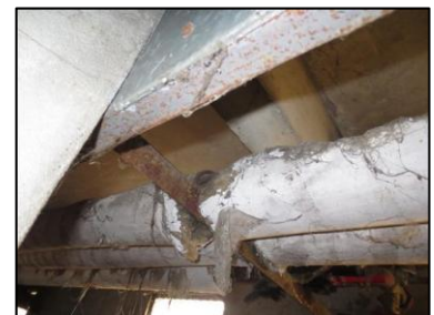
Photo N° 730 AMIANTE CIMENT 17 COUPERIN--LOCAL V.O RDC à +4 Vide-ordures Gaine V.O.(Fibres-ciment)
