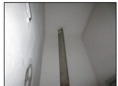
Photo N° 697 AMIANTE CIMENT 1 ST EXUP- +4-LOCAL V.O Vide-ordures Ventilation haute (Fibres-ciment)
