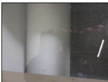
Photo N° 694 AMIANTE CIMENT 7 SAINT EXUPERY-RDC à +4- LOCAL V.O Vide-ordures Gaine V.O.(Fibres-ciment)
