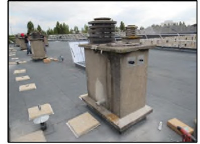
Photo N° 68 AMIANTE CIMENT 1-4ème-Toiture Terrasse_1_4ème Conduits de ventilation Ventilation haute (Fibres- ciment)
