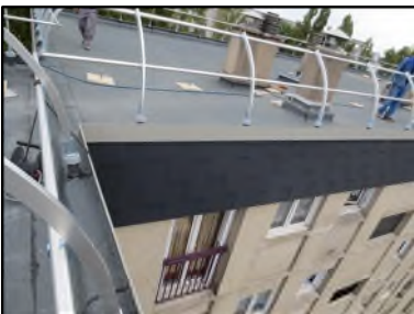
Photo N° 69 ECH-N°3 Toiture Façade terrasse Ardoise noire
