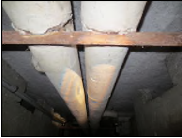
Photo N° 106 ECH-N°2 CALORIFUGEAGE 1-S.sol Conduits de fluide Laine minérale + enveloppe plâtrée
