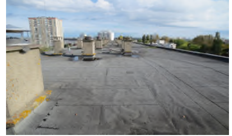
Photo N° 68 AMIANTE CIMENT 1-4ème-Toiture Terrasse_1_4ème Conduits de ventilation Ventilation haute (Fibres- ciment)
