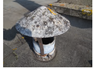
Photo N° 68 AMIANTE CIMENT 1-4ème-Toiture Conduits de ventilation Ventilation haute (Fibres-ciment)
