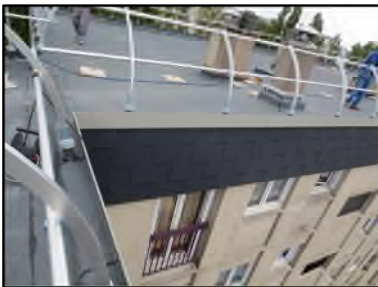
Photo N° 69 ECH-N°3 Toiture Façade terrasse Ardoise noire
