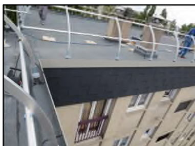
Photo N° 69 ECH-N°3 Toiture Façade terrasse Ardoise noire
