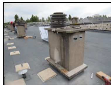
Photo N° 68 AMIANTE CIMENT 1-4ème-Toiture Terrasse_1_4ème Conduits de ventilation Ventilation haute (Fibres- ciment)
