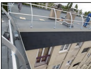
Photo N° 69 ECH-N°3 Toiture Façade terrasse Ardoise noire
