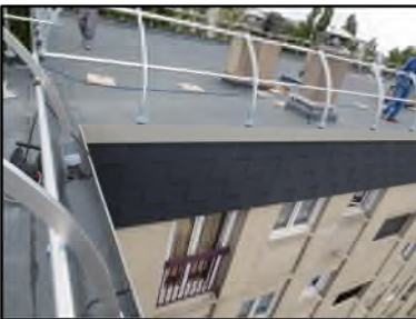
Photo N° 69 ECH-N°3 Toiture Façade terrasse Ardoise noire
