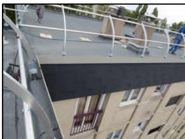
Photo N° 69 ECH-N°3 Toiture Façade terrasse Ardoise noire
