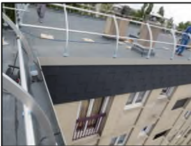
Photo N° 69 ECH-N°3 Toiture Façade terrasse Ardoise noire
