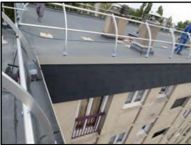
Photo N° 69 ECH-N°3 Toiture Façade terrasse Ardoise noire
