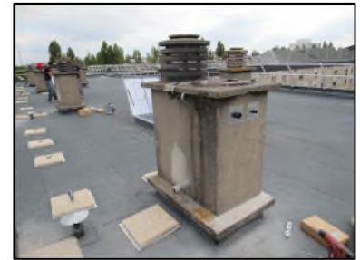
Photo N° 68 AMIANTE CIMENT 1-4ème-Toiture Terrasse_1_4ème Conduits de ventilation Ventilation haute (Fibres- ciment)
