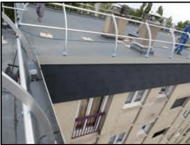
Photo N° 69 ECH-N°3 Toiture Façade terrasse Ardoise noire
