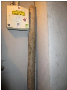
Photo N° 800 AMIANTE CIMENT 3 LORIENT--LOCAL V.O +1 à +8 Vide- ordures Gaine V.O.(Fibres-ciment)
