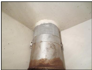
Photo N° 685 AMIANTE CIMENT 3 LORIENT--RDC-V.O Vide-ordures Gaine V.O.(Fibres-ciment)
