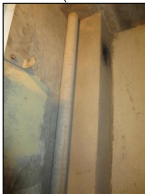
Photo N° 803 AMIANTE CIMENT 4 LORIENT--LOCAL V.O +7 à +8 Conduits de fluide Chute E.P.(Fibres-ciment)
