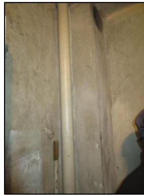
Photo N° 686 AMIANTE CIMENT 5 LORIENT--LOCAL V.O +7 à +8 Conduits de fluide Chute E.P.(Fibres- ciment)
