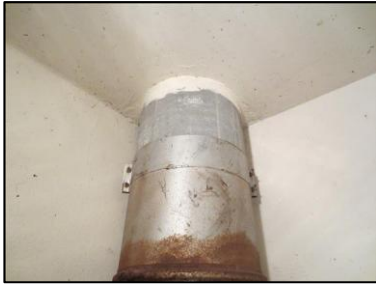
Photo N° 685 AMIANTE CIMENT 6 LORIENT-RDC-V.O Vide-ordures Gaine V.O.(Fibres-ciment)
