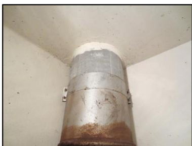
Photo N° 685 AMIANTE CIMENT 6 LORIENT-RDC-V.O Vide-ordures Gaine V.O.(Fibres-ciment)
