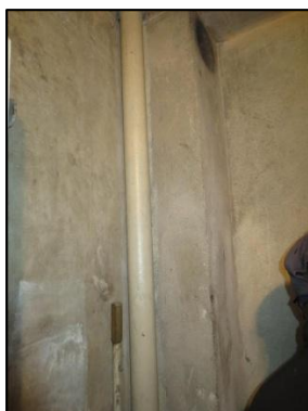
Photo N° 686 AMIANTE CIMENT 6 LORIENT--LOCAL V.O +7 à +8 Conduits de fluide Chute E.P.(Fibres-ciment)
