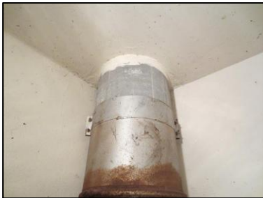
Photo N° 685 AMIANTE CIMENT 8 LORIENT-RDC-V.O Vide-ordures Gaine V.O.(Fibres-ciment)
