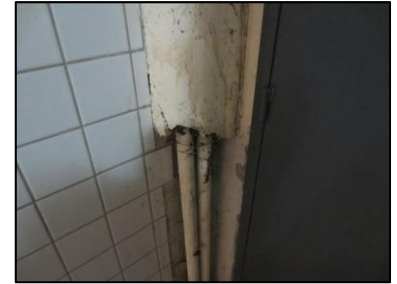
Photo N° 687 ECH-N°1 CALORIFUGEAGE 9 LORIENT- RDC-LOCAL V.O Conduits de fluide Liège + plâtre
