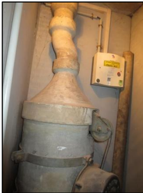
Photo N° 799 AMIANTE CIMENT 10 LORIENT--LOCAL V.O +1 à +8 Vide- ordures Gaine V.O.(Fibres-ciment)
