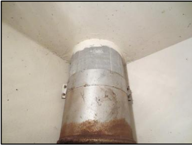
Photo N° 685 AMIANTE CIMENT 11 LORIENT-RDC-LOCAL V.O Conduits de fluide Gaine V.O.(Fibres-ciment)
