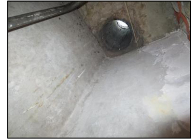
Photo N° 704 AMIANTE CIMENT 11 LORIENT--PLACARDS GAZ +9 Gaines & coffres verticaux Ventilation haute (Fibres-ciment)
