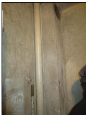
Photo N° 686 AMIANTE CIMENT 11 LORIENT--LOCAL V.O +8 +9 Conduits de fluide Chute E.P.(Fibres-ciment)
