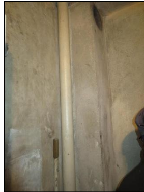
Photo N° 686 AMIANTE CIMENT 2 LORIENT-9ème-MACHINERIE ASCENCEUR Conduits de fluide Chute E.U.(Fibres-ciment)
