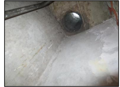
Photo N° 704 AMIANTE CIMENT 2 LORIENT--PLACARDS GAZ +8 Plafonds Ventilation haute (Fibres- ciment)
