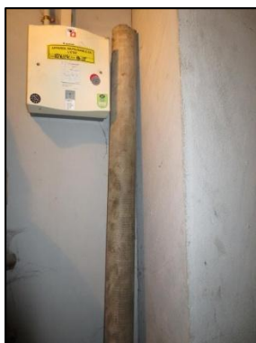
Photo N° 800 AMIANTE CIMENT 2 LORIENT--LOCAL V.O +7 à +8 Dépot de conduits de fluide Chute E.P.(Fibres-ciment)
