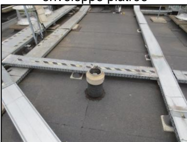
Photo N° 722 AMIANTE CIMENT 13 LORIENT-16ème-EDICULES ANTENNES TELEPHONNES Toiture Conduit + Chapeau (Fibres-ciment)
