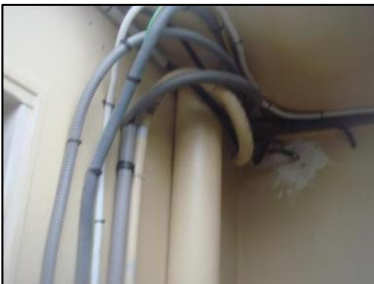
Photo N° 5754 AMIANTE CIMENT 13 LORIENT--PALIER + 15 Poteaux Ventilation haute (Fibres-ciment)
