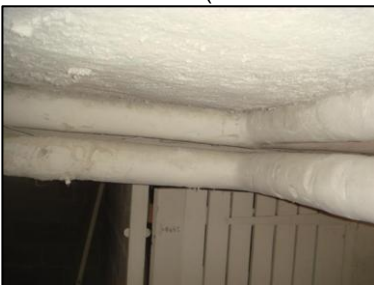
Photo N° 5760 ECH-N°13 CALORIFUGEAGE 13 LORIENT-S- SOL -COULOIRS DE CAVES Conduits de fluide Laine minérale + enveloppe plâtrée
