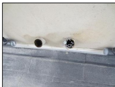
Photo N° 723 ECH-N°1 AMIANTE CIMENT 13 LORIENT-16ème- TOITURE TERRASSE Toiture Ventilation basse x4 (Fibres-ciment)
