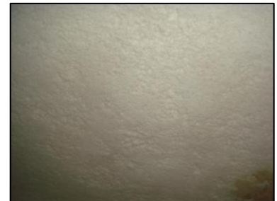
Photo N° 5759 ECH-N°14 FLOCAGE 13 LORIENT-S-SOL-COULOIRS DE CAVES Plafonds flocage
