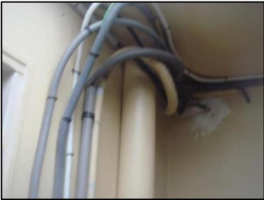
Photo N° 5754 AMIANTE CIMENT 13 LORIENT--PALIER + 15 Poteaux Ventilation haute (Fibres-ciment)
