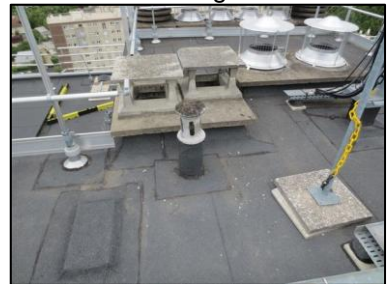
Photo N° 720 AMIANTE CIMENT 13 LORIENT-16ème-EDICULES ANTENNES TELEPHONNES Toiture Chapeau (Fibres-ciment) X2
