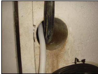
Photo N° 5758 AMIANTE CIMENT 13 LORIENT-S.sol-COULOIRS DE CAVES Murs Fourreau
