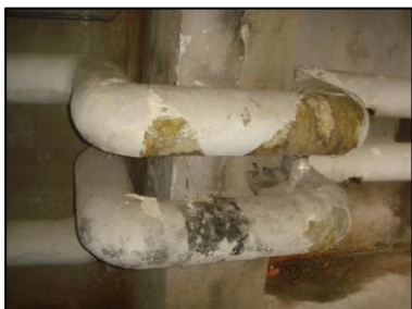
Photo N° 5762 ECH-N°015 CALORIFUGEAGE SOUS STATION 13 LORIENT-S.sol-SOUS STATION Conduits de fluide Laine minérale + enveloppe plâtrée
