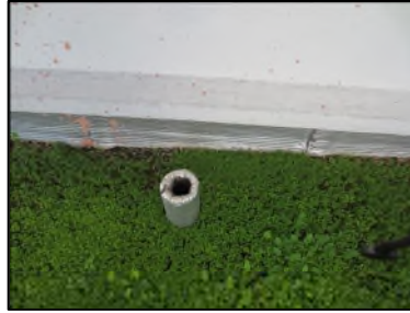
Photo N° 125 AMIANTE CIMENT - Toiture-terrasse Toiture Conduits Ventilation haute (Fibres-ciment)
