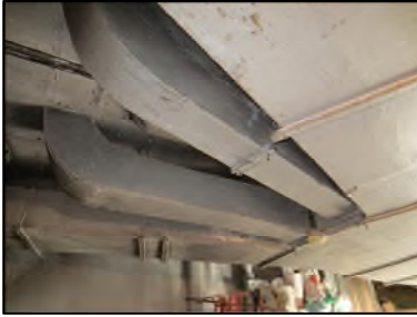
Photo N° 121 AMIANTE CIMENT Atelier 3__RDC Gaines & coffres horizontaux Ventilation haute (Fibres-ciment)
