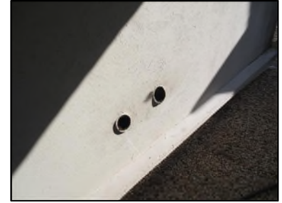
Photo N° 127 AMIANTE CIMENT Conduits Ventilation basse (Fibres- ciment)
