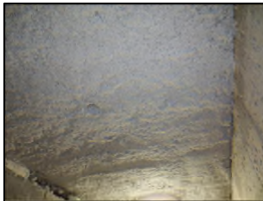
Photo N° 72 ECH-N°1 FLOCAGE S.sol 1 Plafonds Cotonneux blanc
