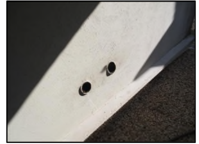
Photo N° 127 AMIANTE CIMENT Conduits Ventilation basse (Fibres- ciment)
