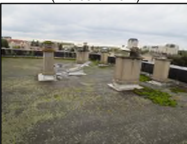
Photo N° 141 ECH-N°3 AMIANTE CIMENT --Toiture Planchers Bitume noir
