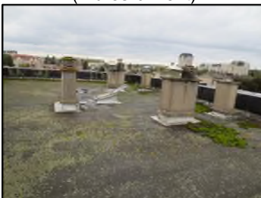
Photo N° 141 ECH-N°3 AMIANTE CIMENT --Toiture Planchers Bitume noir
