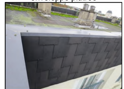
Photo N° 140 ECH-N°4 AMIANTE CIMENT Toiture Façade Plaques planes (Fibres-ciment)
