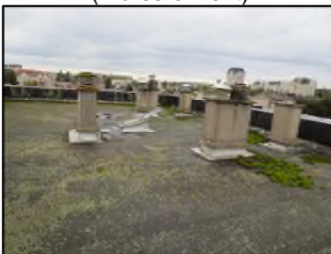
Photo N° 141 ECH-N°3 AMIANTE CIMENT --Toiture Planchers Bitume noir
