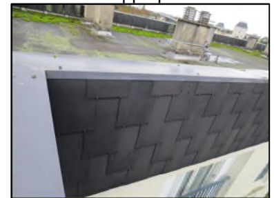
Photo N° 140 ECH-N°4 AMIANTE CIMENT Toiture Façade Plaques planes (Fibres-ciment)
